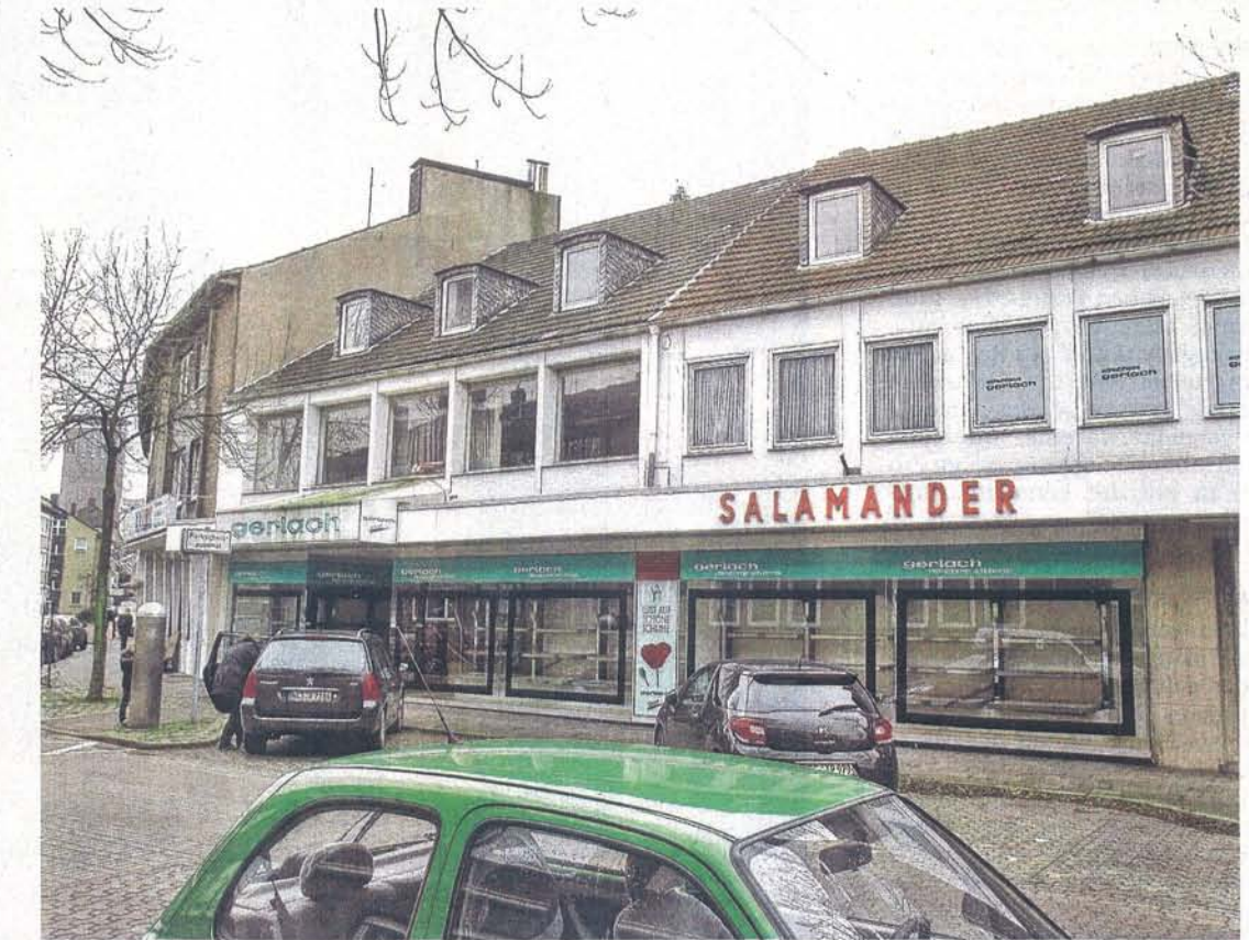
Mehrere Monate stand das Ex-Schuhhaus Gerlach leer. Nun sind Arbeiter damit beschäftigt, das Geschäft zu entkernen und dann umzubauen. Das Erdgeschoss soll an eine Arztpraxis oder Anwaltskanzlei vermietet werden. RP-FOTO: MALZ.
